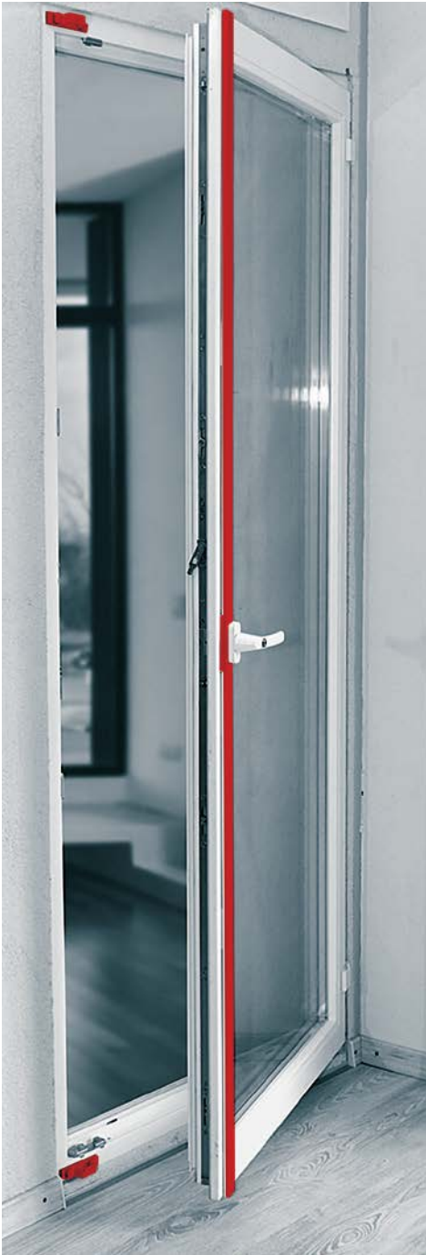
Illustration 10 : Crémone d'une porte vitrée de balcon
