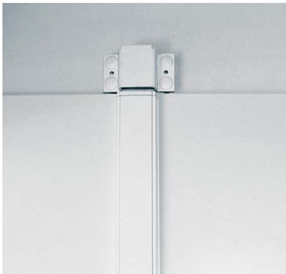
Illustration 7: Crémone avec point de fermeture en haut
